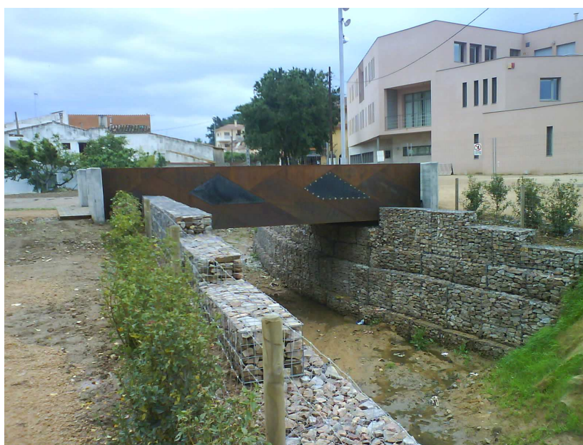
Vista de la passera peatonal sobre la riera Vila-seca
