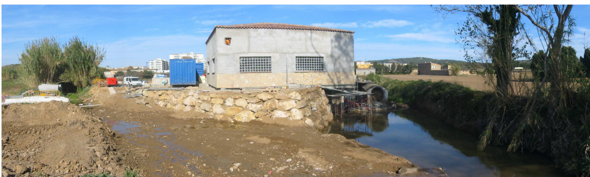
Vista de l'obra acabada del nou sobreexidor
